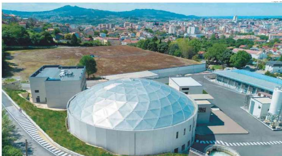
Planta potabilizadora O Casal, en Vigo, con su característica cúpula de aluminio de 39 metros de diámetro
