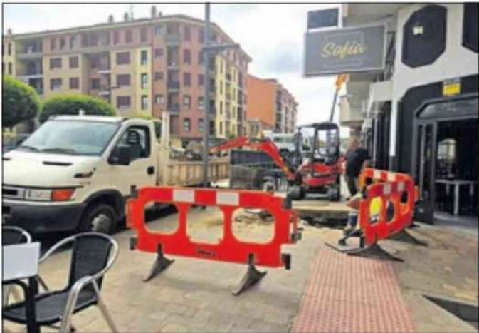
En muchos puntos se están cambiando las canalizaciones. DL
