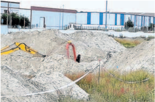
Obras, ahora paralizadas, de la planta de biogás en el polígono. c. c.
